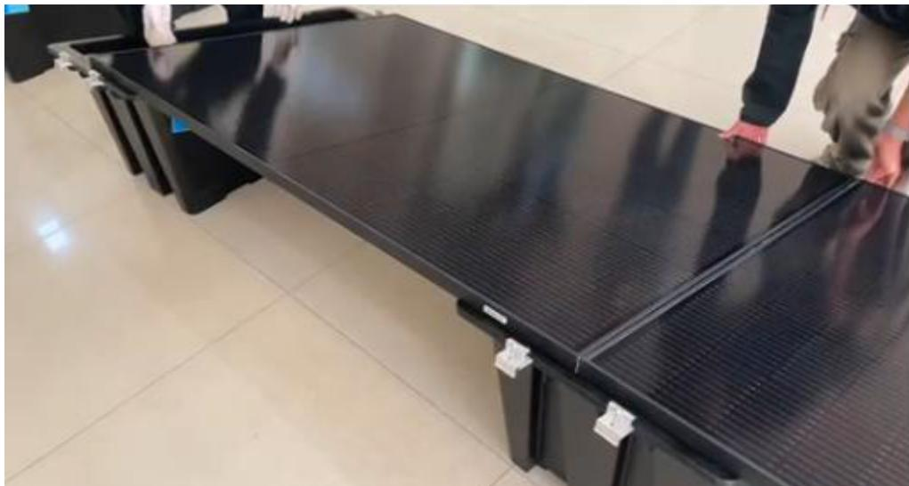
9. Nachdem die Position der Solarmodule überprüft wurde, ziehen Sie die Schrauben an den Klemmen fest, um die Module zu fixieren.
