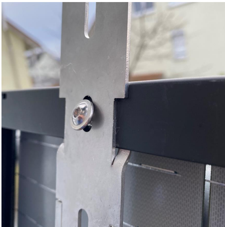
Abb. 5/locker angesetzte Schraube M6 kurz
