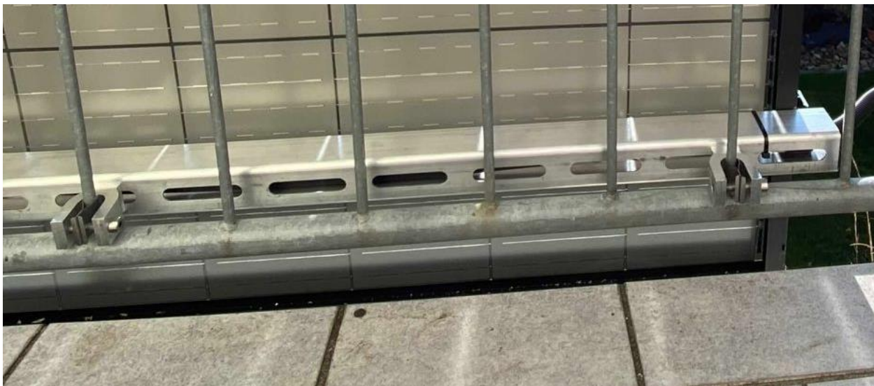
Abb. 10/ Montageschiene an Spezialklemme
