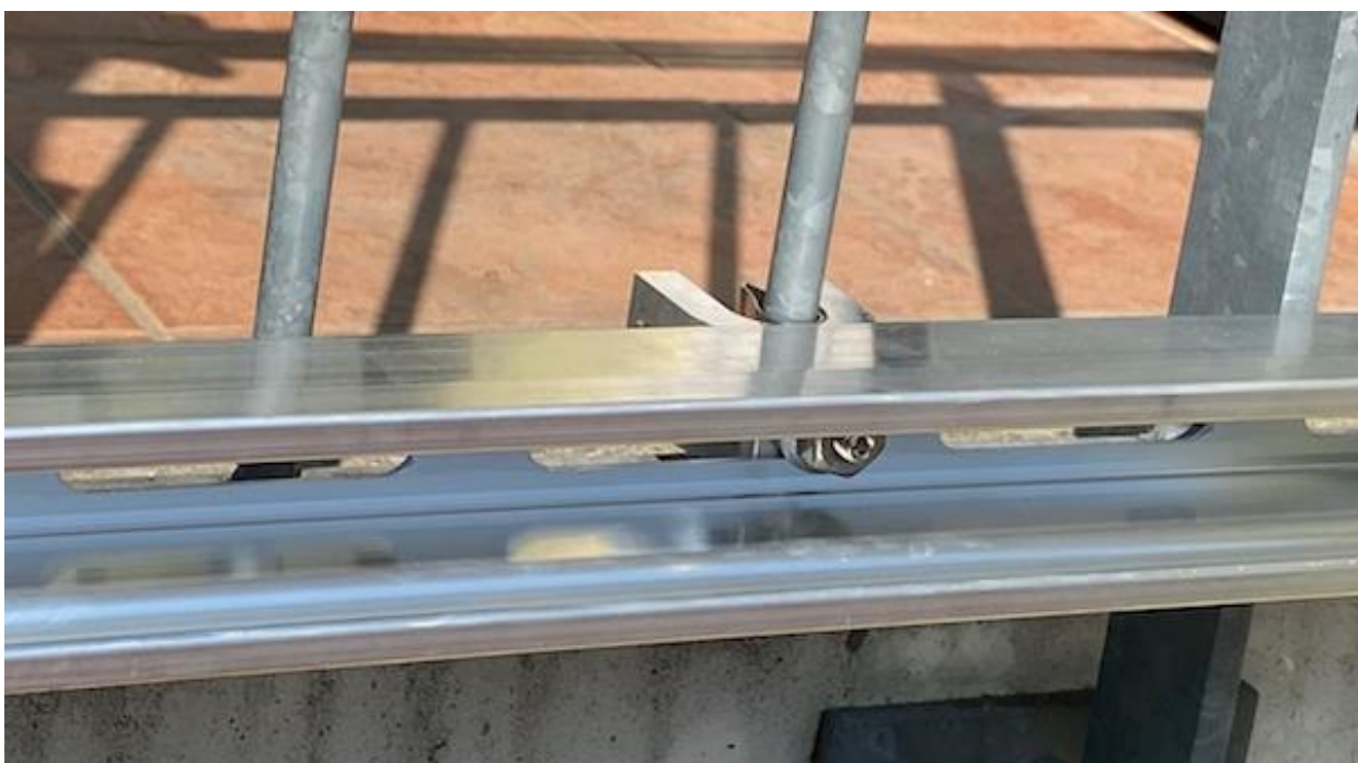
Abb.g 11/Montageschiene und Spezialklemme von außen
